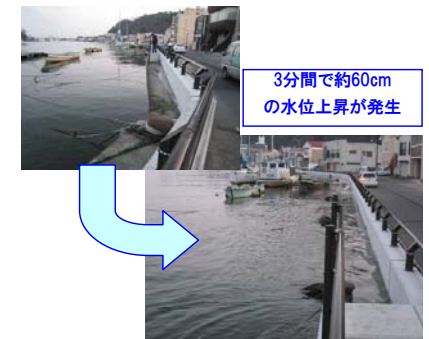
チリ地震（平成22年） （旧北上川：津波による水位上昇）
