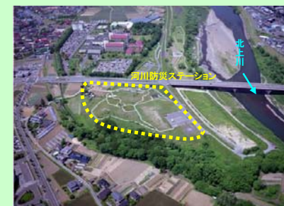
津志田地区河川防災ステーション
