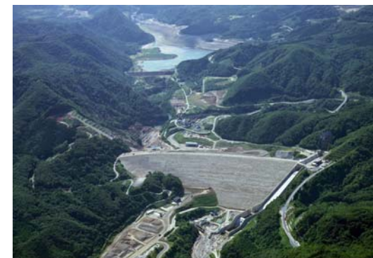
建設中の胆沢ダム
