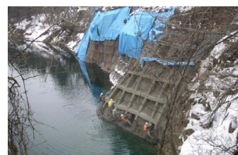
貯水池の法面補修
