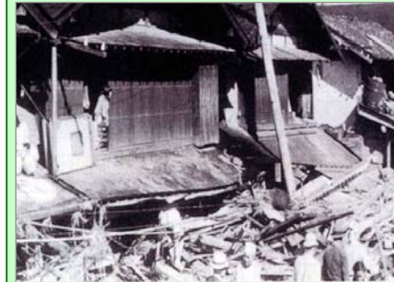
洪水による堆積物が2階まで達した (岩手県一関市大町街路)
