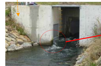
新魚道に設置した観察窓（輪波洗堰）
