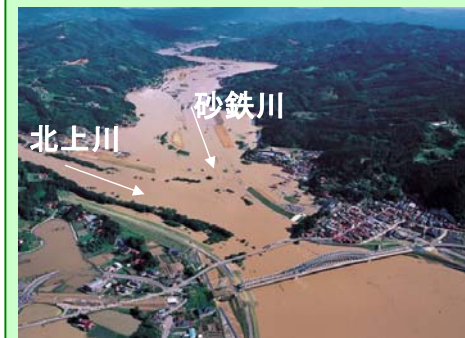
平成14年7月洪水 一関市(旧川崎村)の浸水状況
