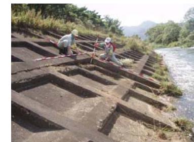
護岸損傷状況の調査
