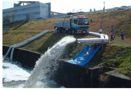
排水ポンプ車の操作訓練
