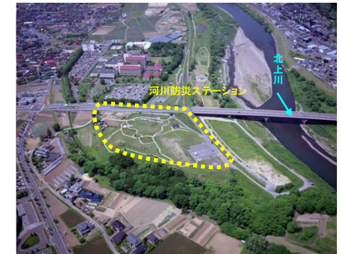
津志田地区河川防災ステーション
