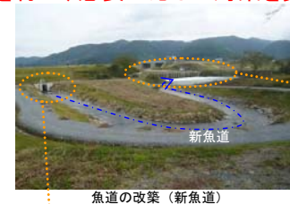
魚道の改築（新魚道）
