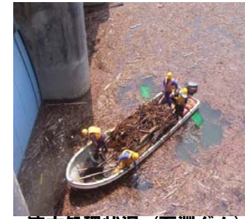
流木処理状況（石淵ダム）
