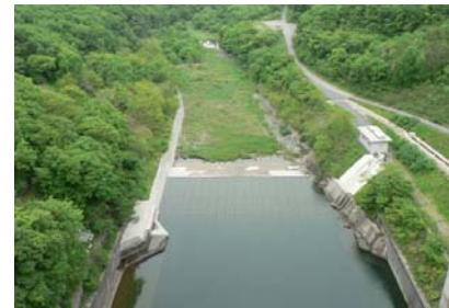
ダム下流の状況(田瀬ダム)
