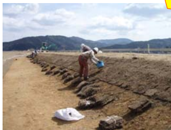
堤防法面補修の実施
