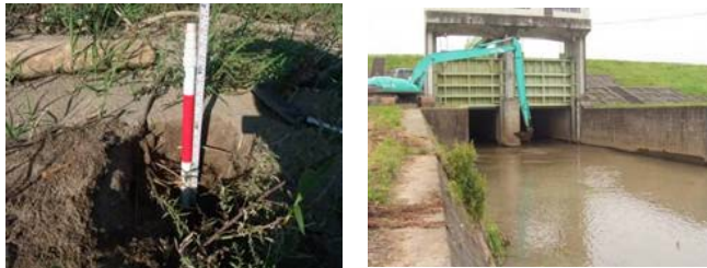
中州に堆積した土砂の状況 排水路に堆積した土砂の撤去
