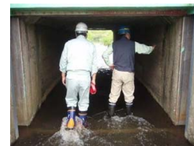
樋管函内の点検状況
