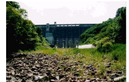
田瀬ダム無水区間の状況(田瀬ダム)
