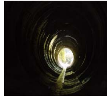
トンネル洪水吐の漏水
