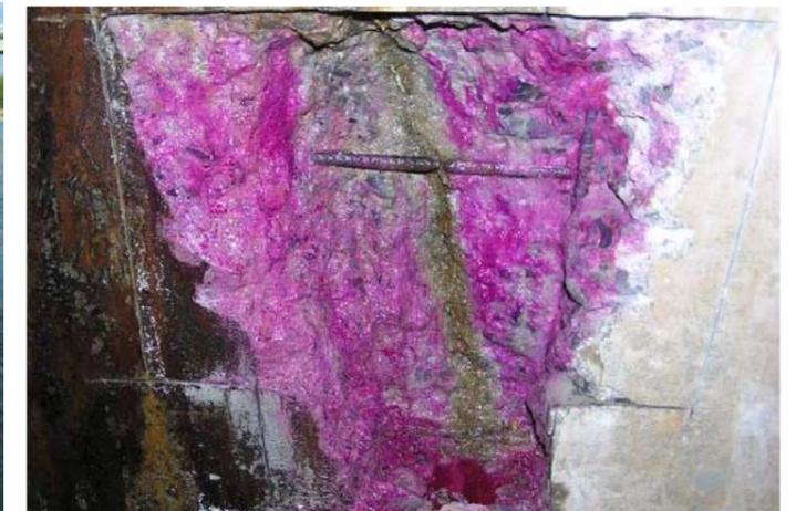
樋管内部の鉄筋腐食状況
