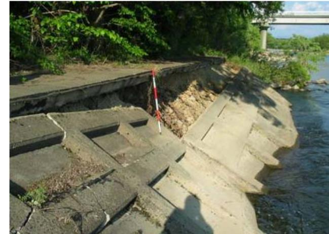
洗掘による護岸崩落状況
