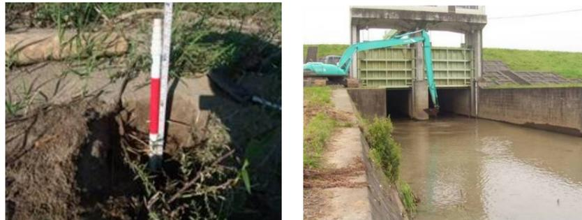
中洲に堆積した土砂の状況 排水路に堆積した土砂の撤去
