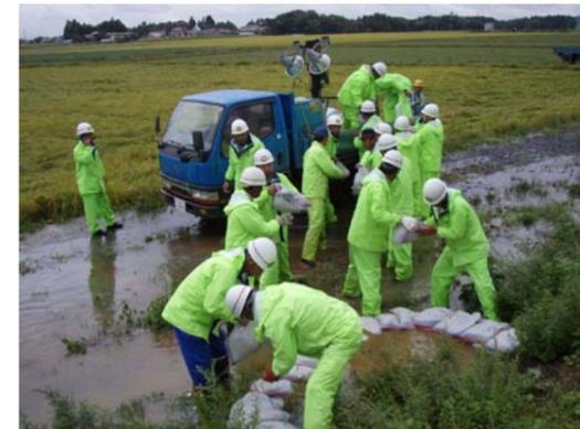
漏水発生箇所の水防活動状況
