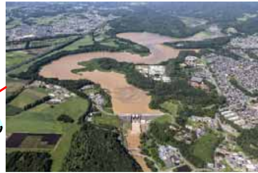
四十田ダムによる貯留状況 (8月25日13時頃)
