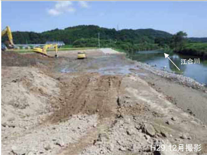
中瀬地区:河道掘削の状況 (涌谷町)
