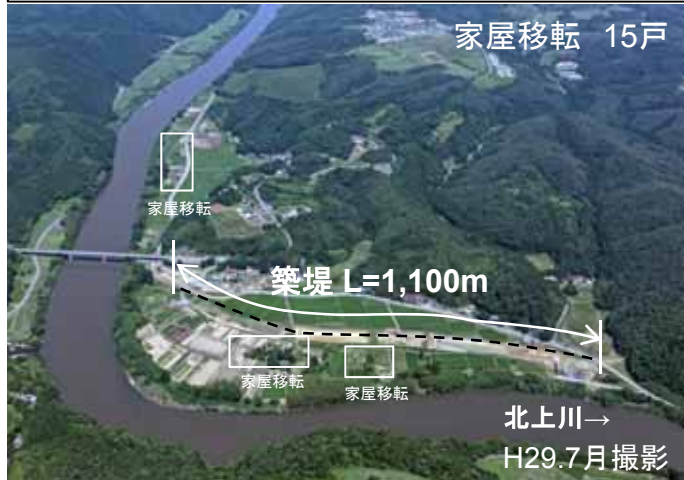
曲田地区：築堤状況（一関市）
