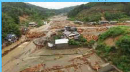
筑後川水系赤谷川(福岡県朝倉市)
