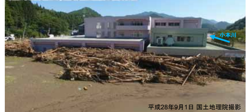
岩泉町乙茂地区の高齢者福祉施設の被災状況
