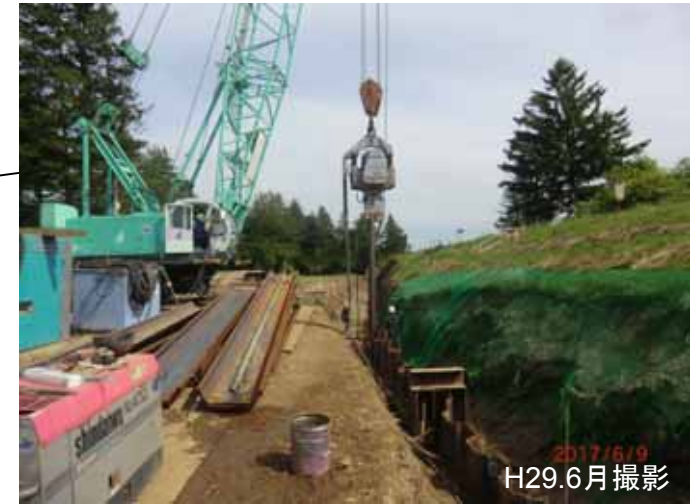
見前地区：堤防浸透対策整備状況（盛岡市）
