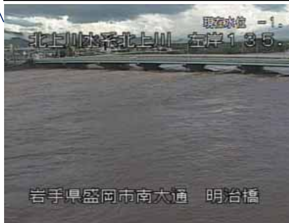
明治橋 水位ピーク時
