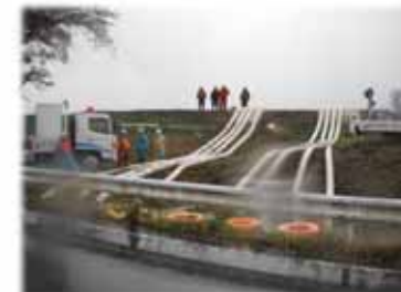
▲排水ポンプ車による内水排除の様子（石巻市横川地区）
