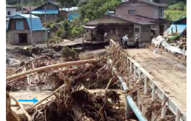
流木による河道閉塞(岩泉町)
