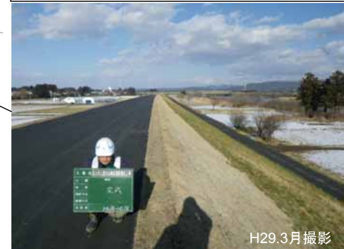
白山地区：堤防浸透対策完成状況（奥州市）
