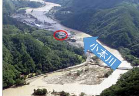
小本川の氾濫状況
