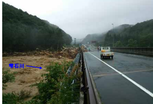
流木阻害による堰上げ(雫石町橋場地区、国道46号)
