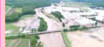
堤防の決壊による氾濫状況 (空知川:北海道南富良野町)
