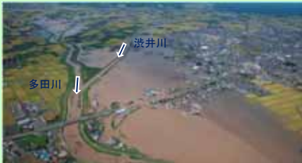
宮城県 大崎市 洪井川の浸水状況
