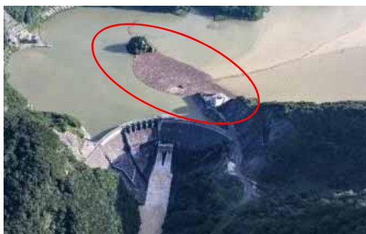
湯田ダムでの流木捕捉状況
