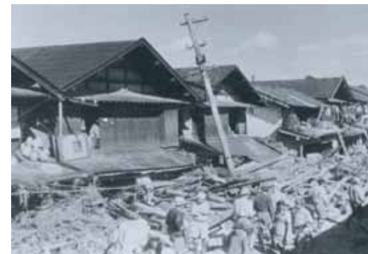
洪水後の被害状況(一関市大町)
