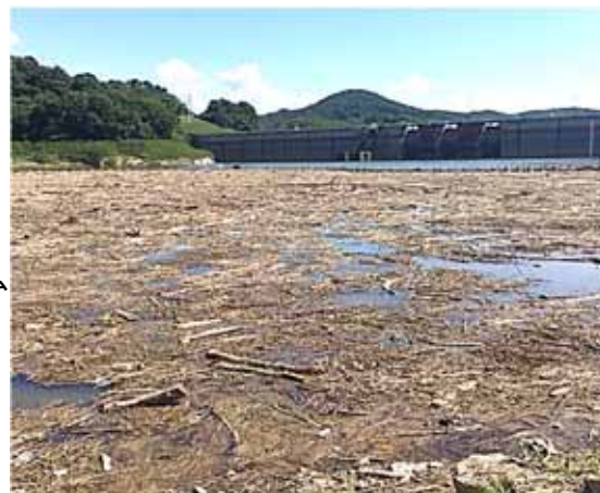
四十四田ダムの洪水後の湖面状況
