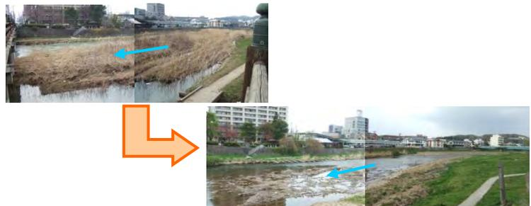
中洲撤去前後の河川の状況(上:撤去前、下:撤去後)
