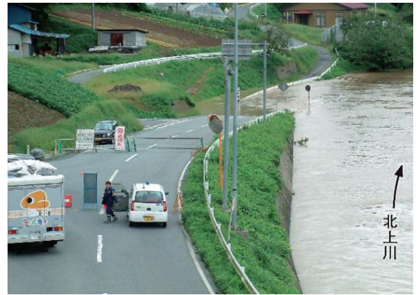
④ (県)薄衣舞川線浸水状況(H19.9洪水) 道路の冠水による交通の途絶
