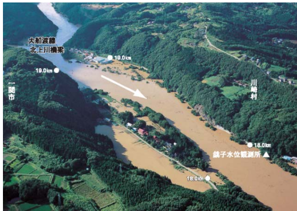
① 小間木地区浸水状況(H14.7洪水) 住宅の浸水被害
