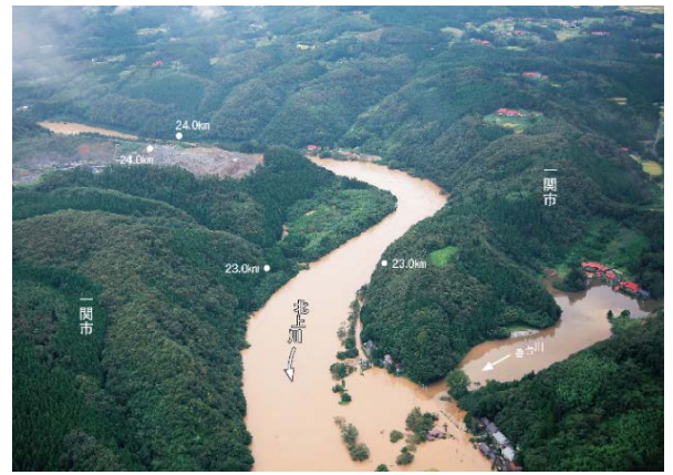
② 番台地区浸水状況(H19.9洪水) 住宅の浸水被害
