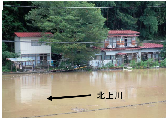
③ 川底地区浸水状況(H19.9洪水) 冠水による孤立
