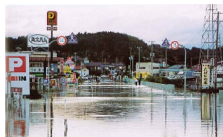
衣川地区では国道 4 号の冠水により交通が麻痺
