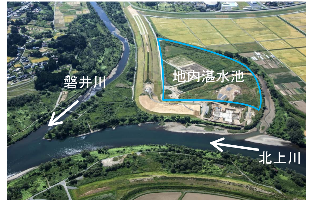
地内湛水池の状況（第一遊水地）
