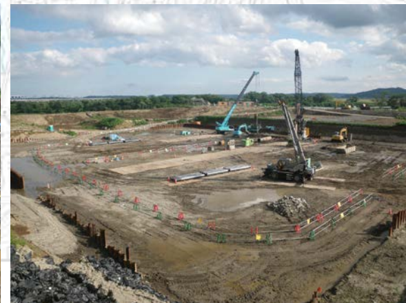
長島水門施工状況 H27.6
