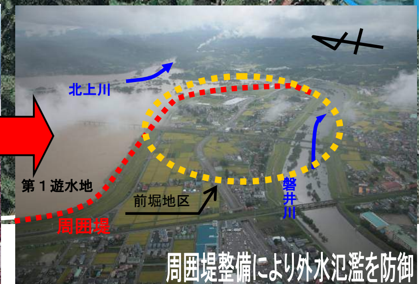
平成19年9月洪水（周囲堤整備後）
