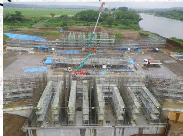
大林水門施工状況 H27.6
