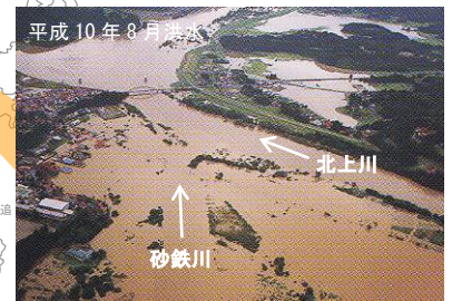
砂鉄川と北上川の合流点付近の浸水状況
