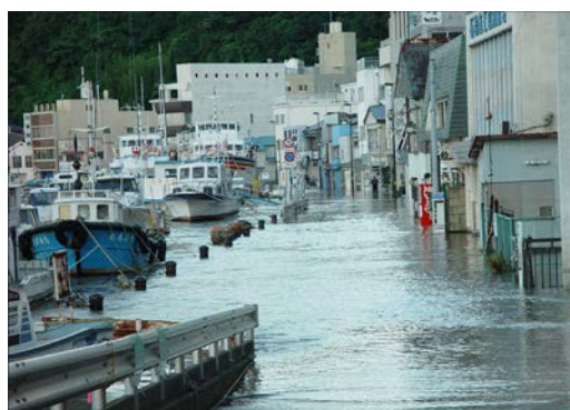
平成14年7月 浸水被害状況
