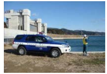
河川巡視状況
