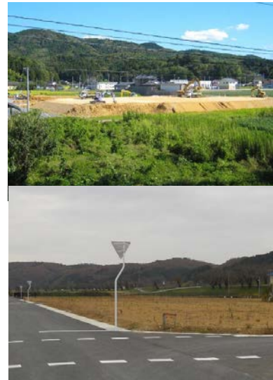
登米市による土地区画と宅地造成の実施状況
