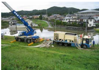
平泉町倉町地区での内水排除状況 (平成 19 年 9 月洪水)
