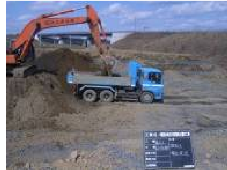
改良状況（一関遊水地衣川築堤工事）
