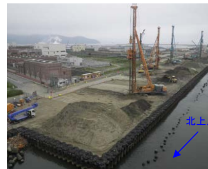
地盤改良工事の施工状況
