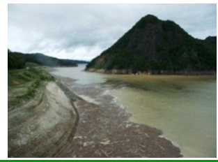
◆胆沢ダム貯水池◆ 洪水を貯め込むと同時に大量の流木も捕捉した
