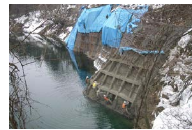
貯水池の法面補修
