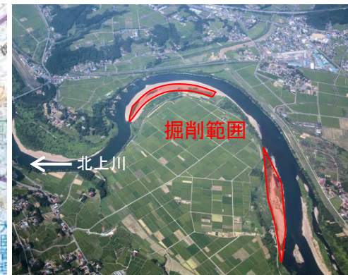
赤生津地区の河道掘削箇所
