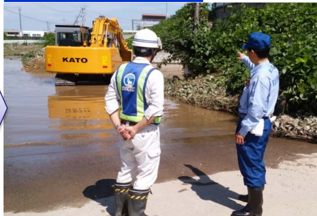
決壊箇所までの工事用道路の敷設
