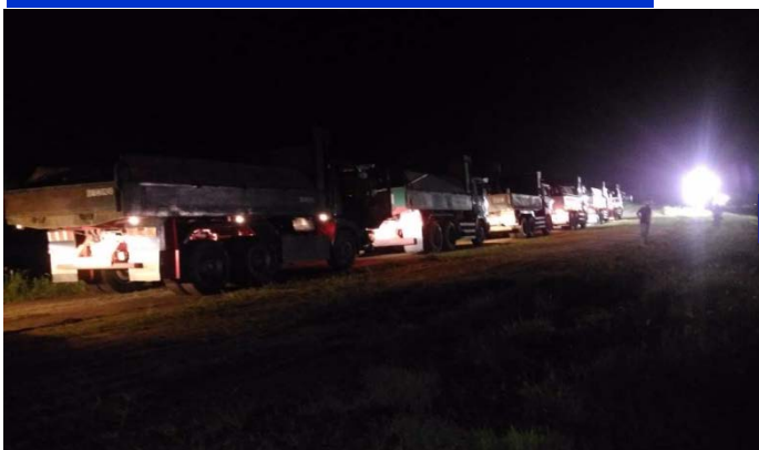
昼夜を分かたず緊急復旧盛土材を搬入
