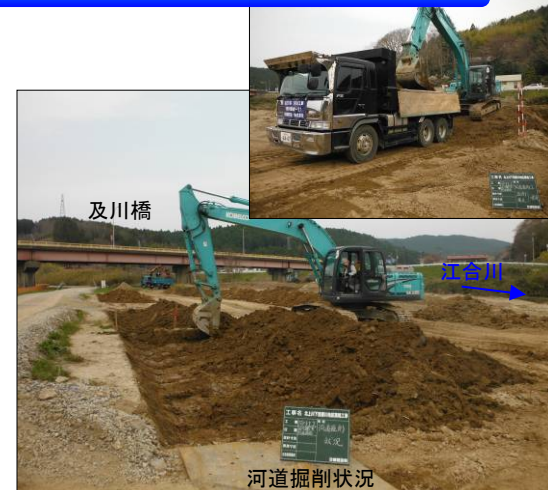
河道掘削土を築堤材へ活用
