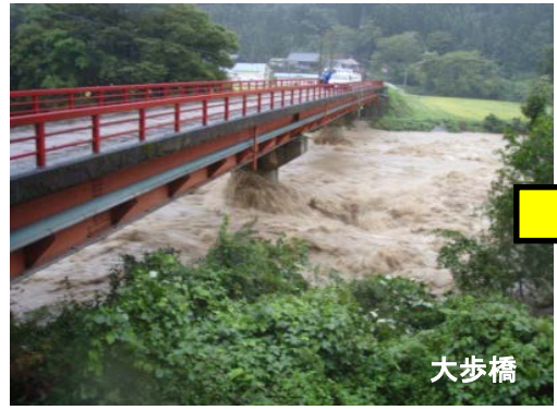
H19. 9洪水(石淵ダム)
