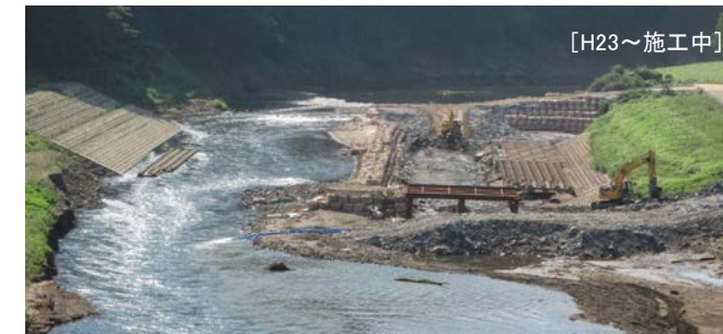
四十四田ダム 貯砂床止め施工状況 (H27.8)
