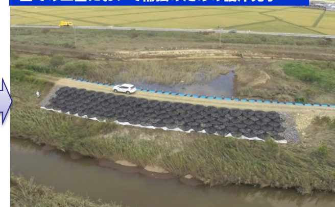
護岸での補強を完了した中流工区の堤防
