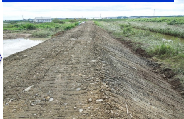
下流工区での盛立完了の様子
