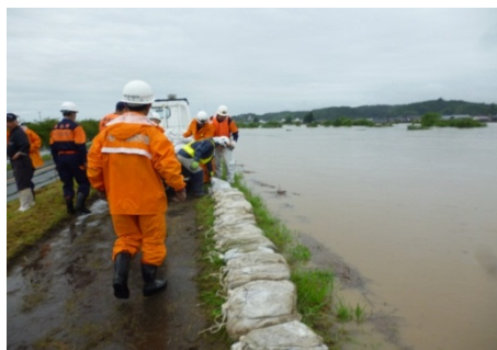
土のう積み工法により堤防の 越水を防止
