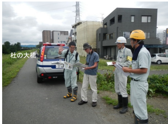
環境保全モニターと伐採範囲の確認
