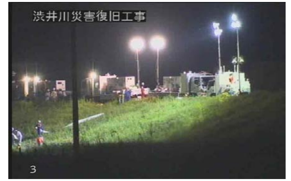
渋井川緊急復旧箇所における排水ポンプの稼働状況
