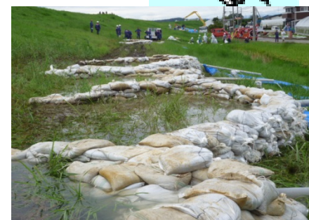
建設業者の重機を活用した月の輪工法による漏水対策を実施
