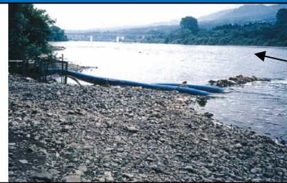
平泉町長島 2段揚水の状況(北上川)
