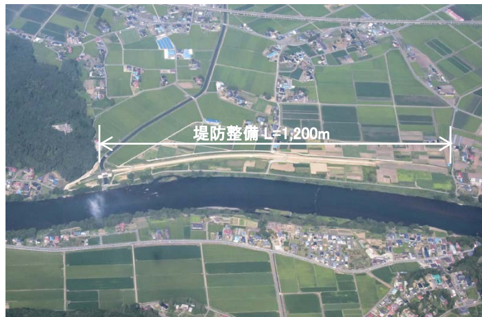
二子地区の堤防整備状況(H27.7)
