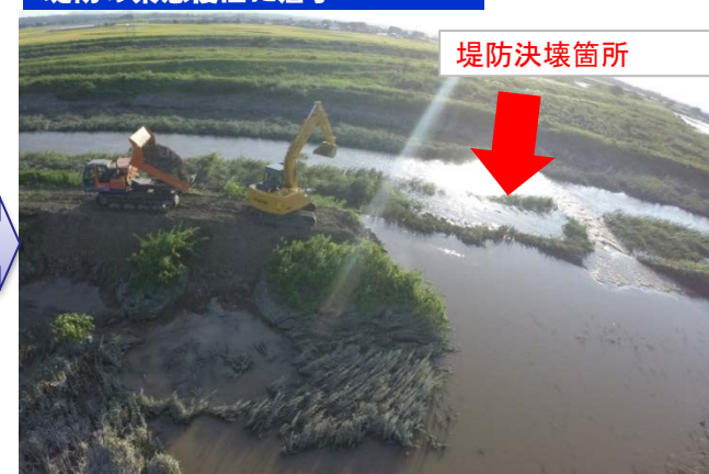
下流工区で堤防盛立に着手
