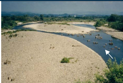
奥州市水沢区 再巡橋(胆沢川)
