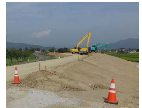
築堤の施工状況
