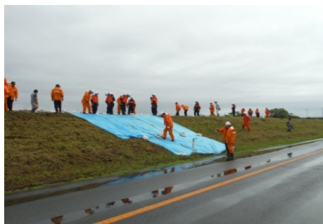
シート張り工法により 堤防の洗掘対策を実施
