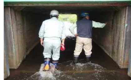
樋管函内の点検状況
