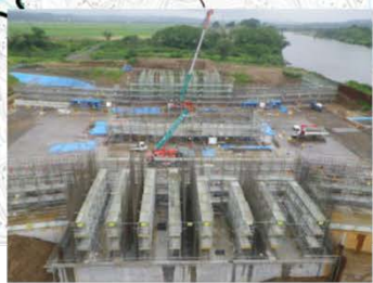
大林水門施工状況 H27.6
