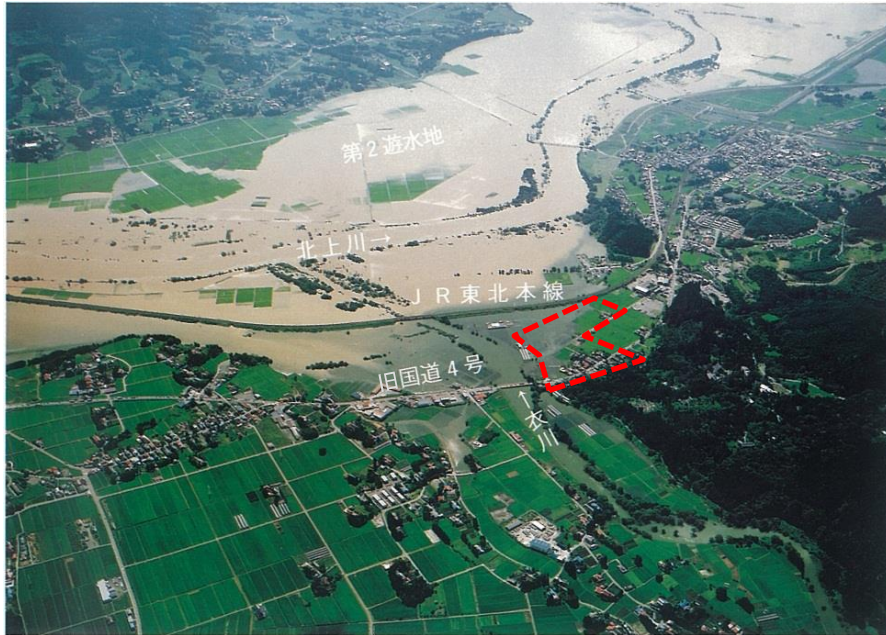
JR衣川橋梁および築堤完成前：平成7年8月洪水時
