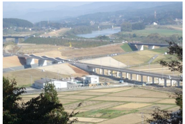
完成状況(H21.10)
