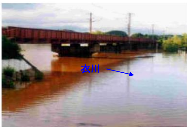
架替前の JR 衣川橋梁
