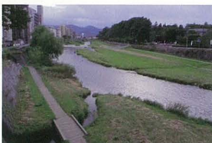
フットパスの分断箇所（中の橋下流左岸）
