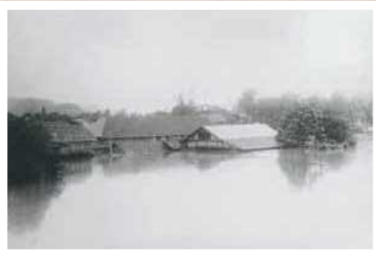
水に沈んだ家(一賀市)
