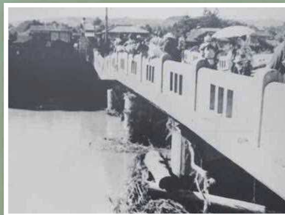
磐井川の上の橋はかるうじて落橋を免れた(一賀市)
