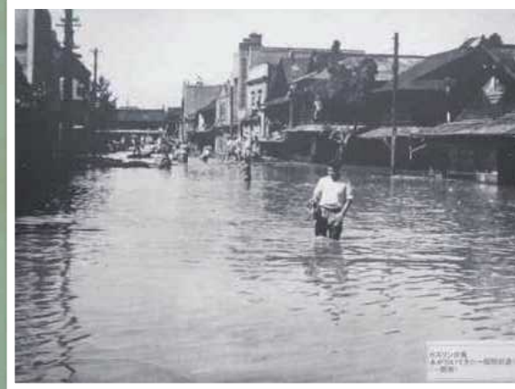
水が引いてきた一賀駅前通(一賀市)
