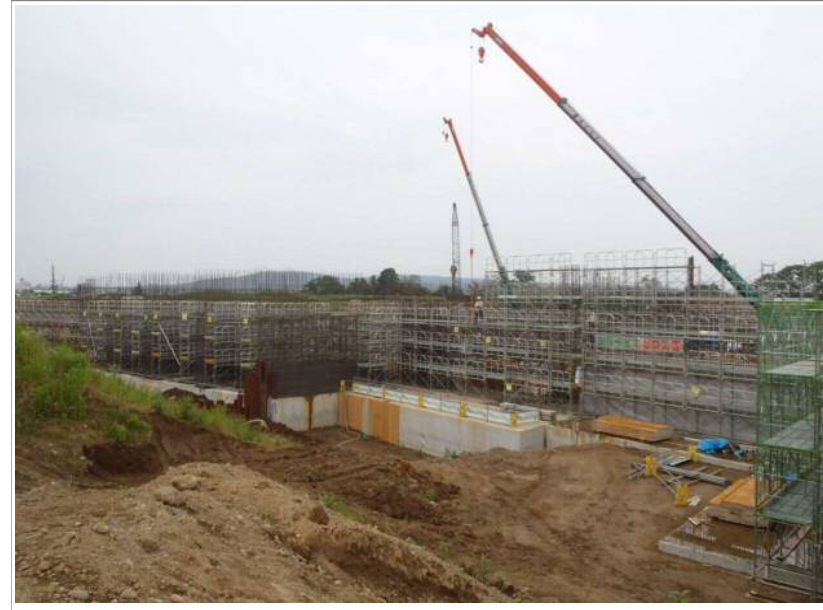
工事写真①
