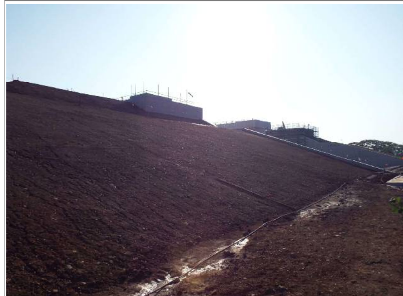
工事写真①
