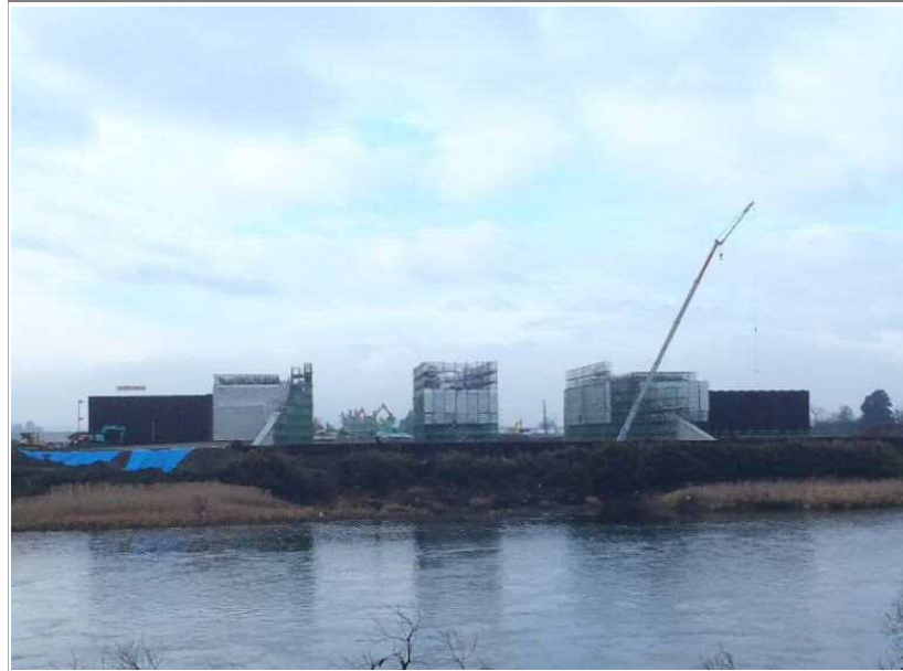
工事写真②
