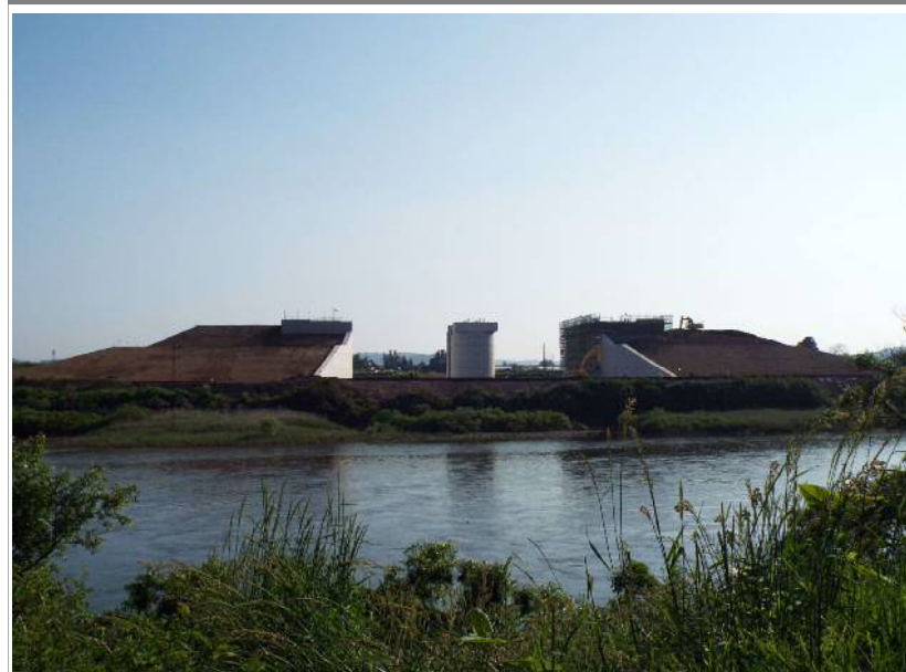
工事写真②
