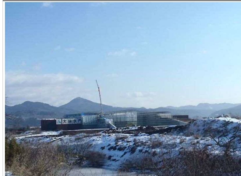
工事写真③
