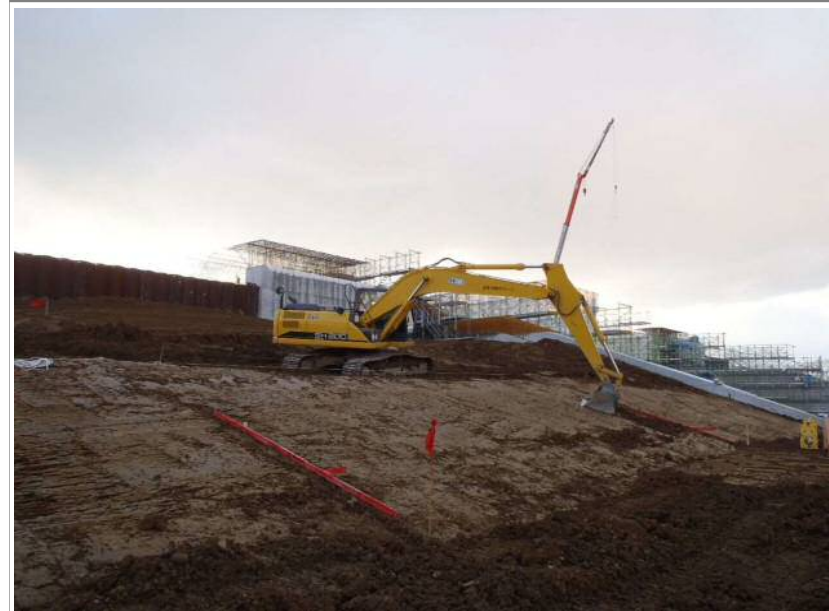
工事写真①
