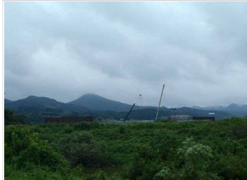
工事写真③
