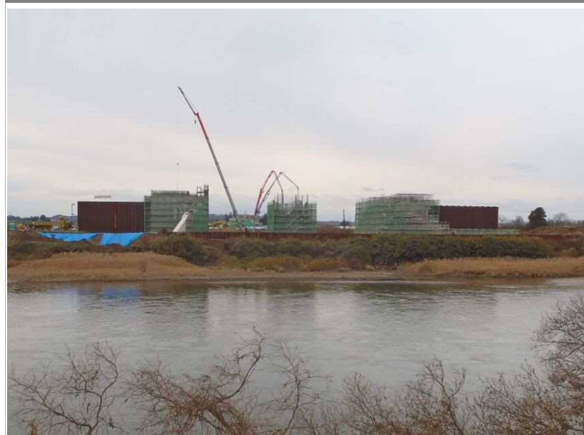
工事写真②
