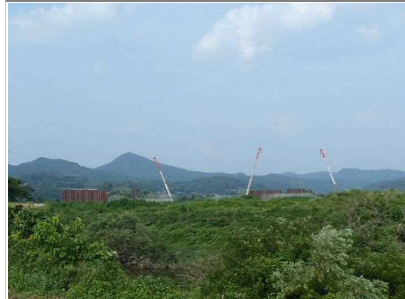
工事写真③
