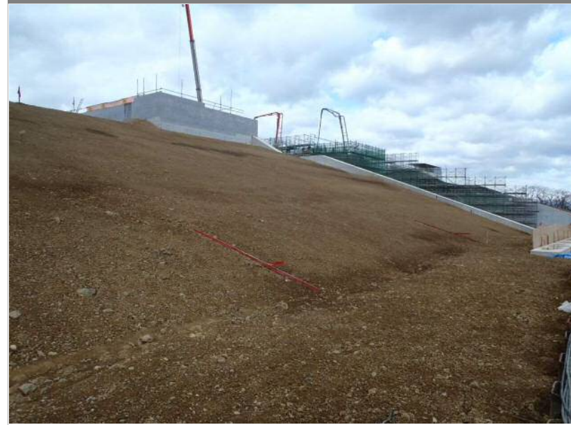
工事写真①
