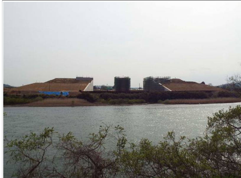
工事写真②
