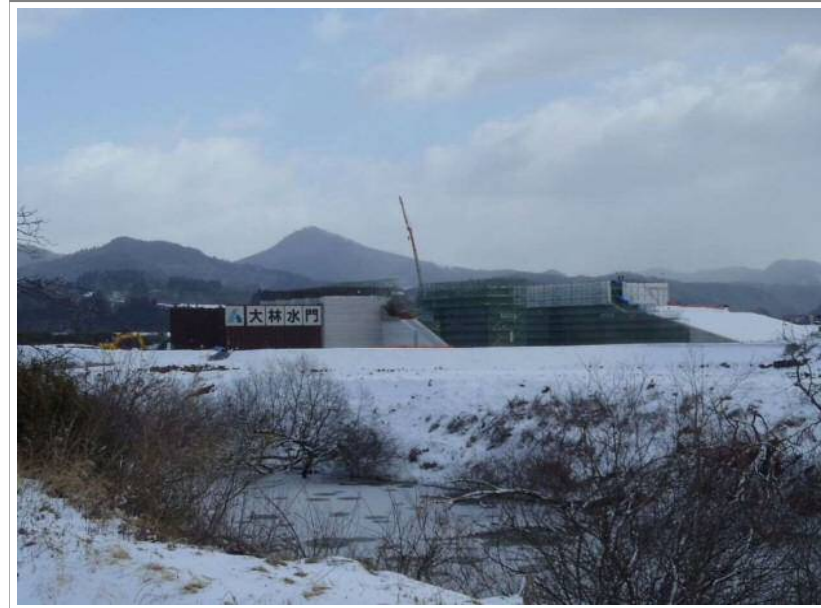
工事写真③
