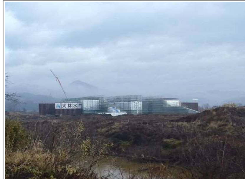
工事写真③
