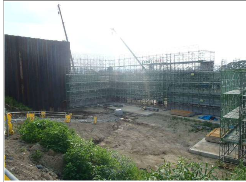
工事写真①
