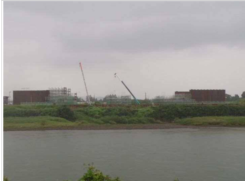
工事写真②
