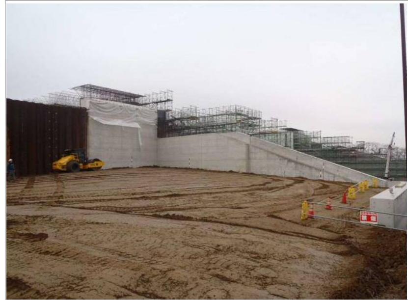
工事写真①
