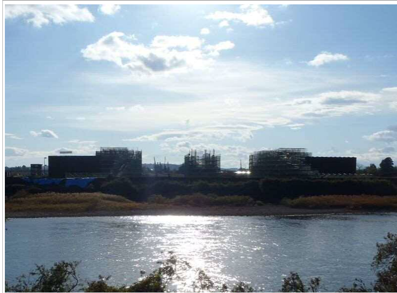
工事写真②
