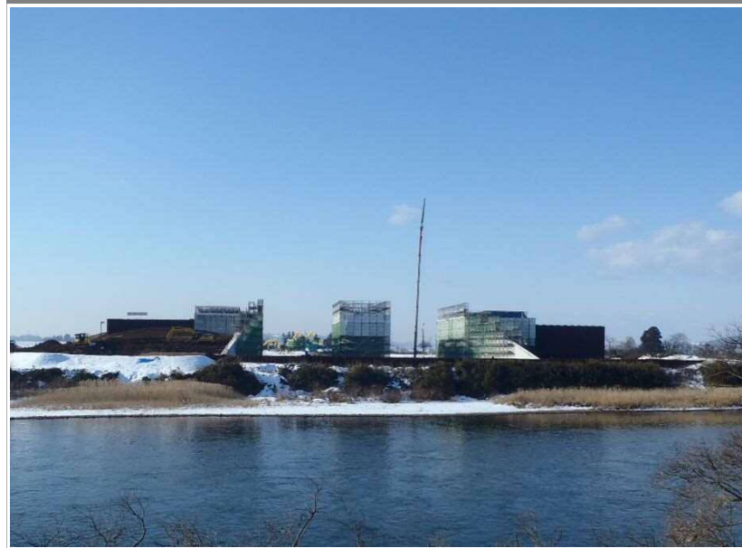
工事写真②
