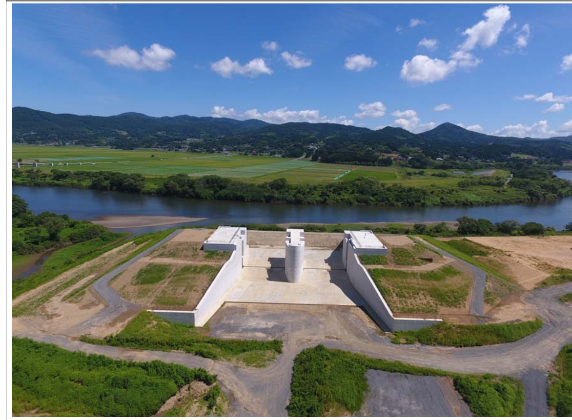
工事写真③
