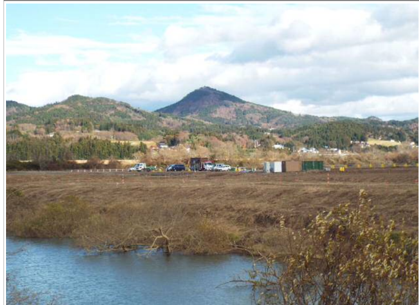
工事写真③
