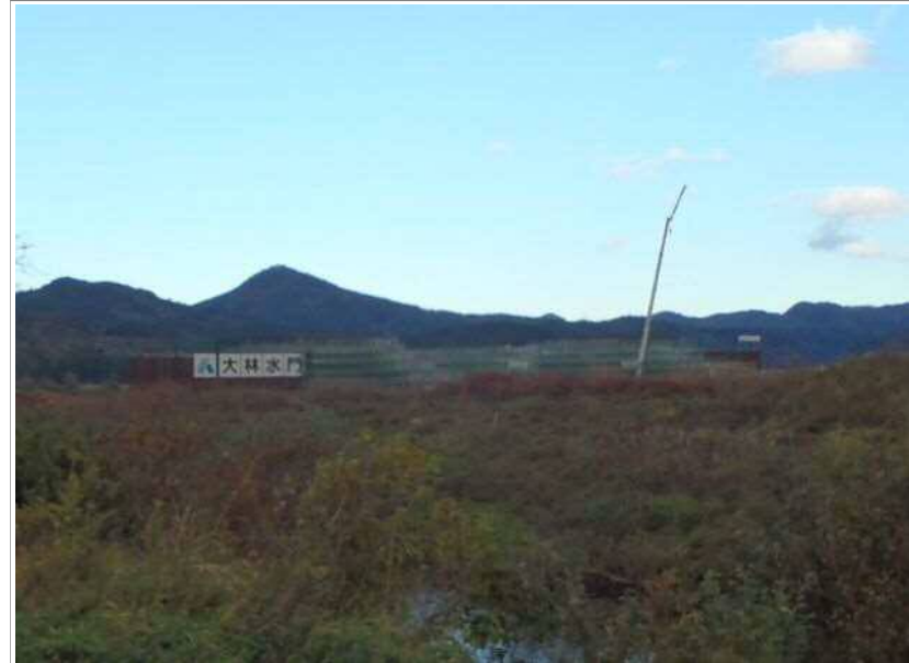
工事写真③
