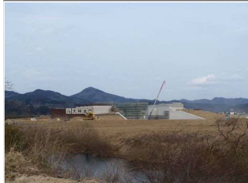
工事写真③
