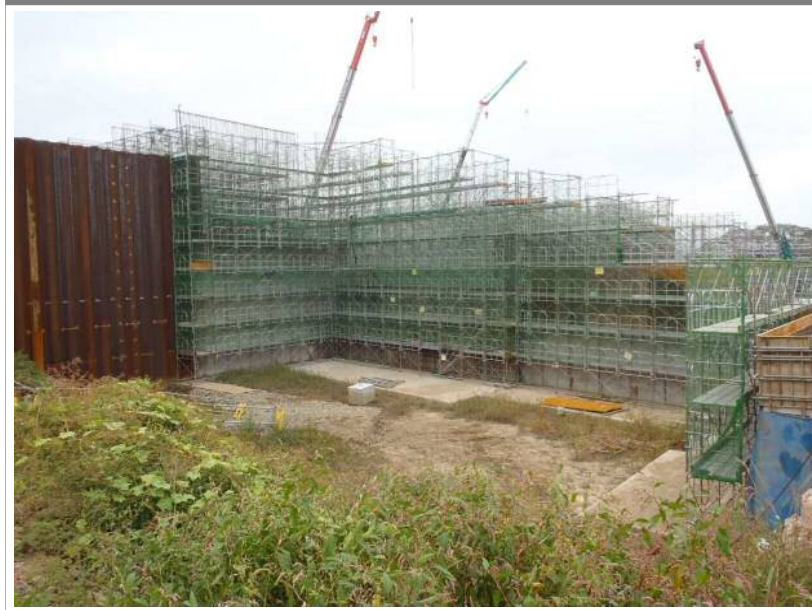
工事写真①
