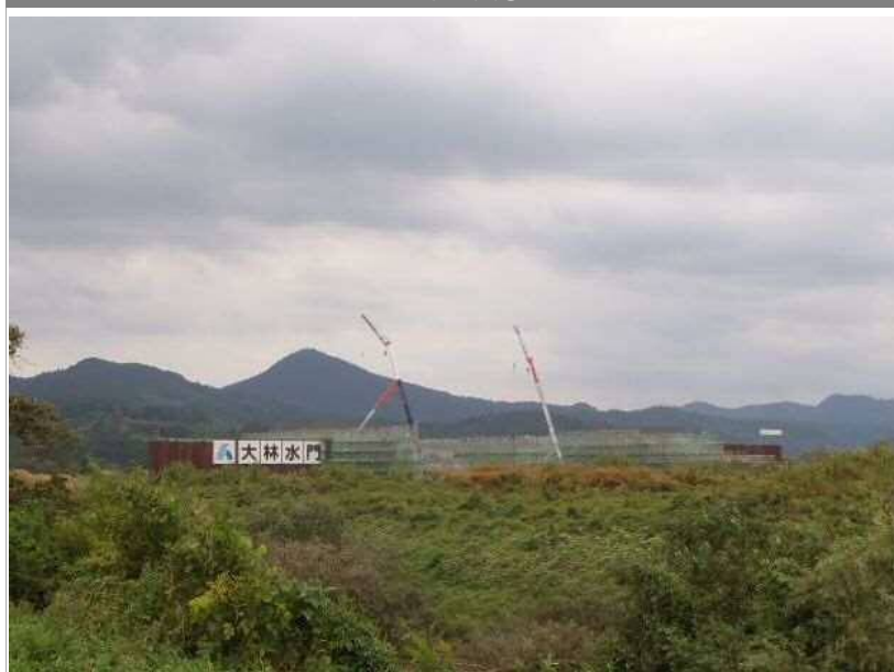
工事写真③
