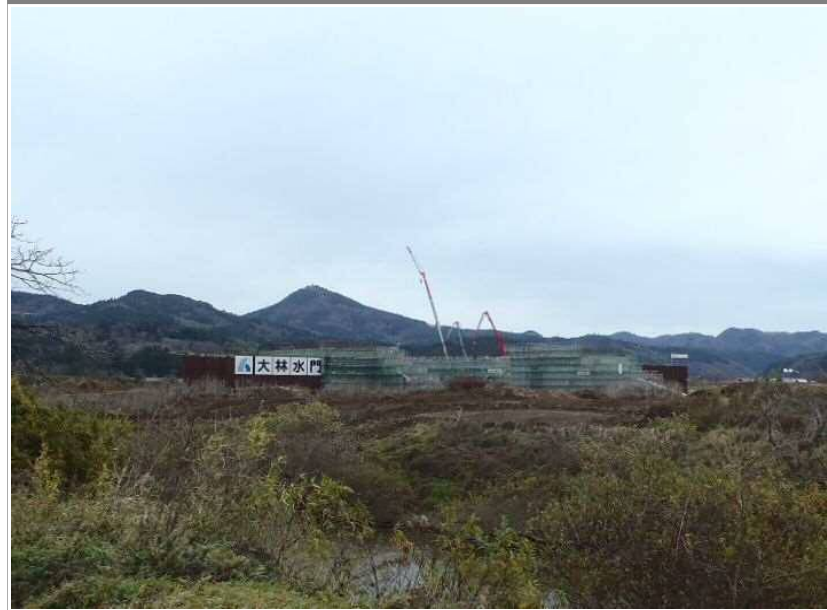
工事写真③
