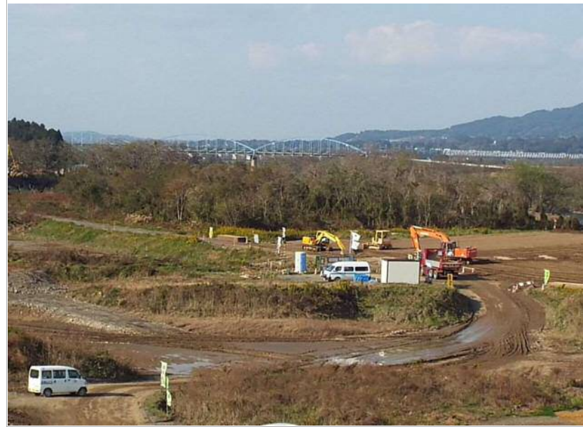
工事写真①
