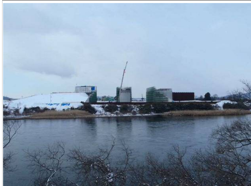
工事写真②
