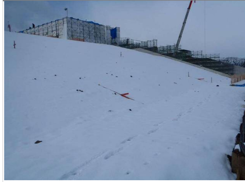
工事写真①
