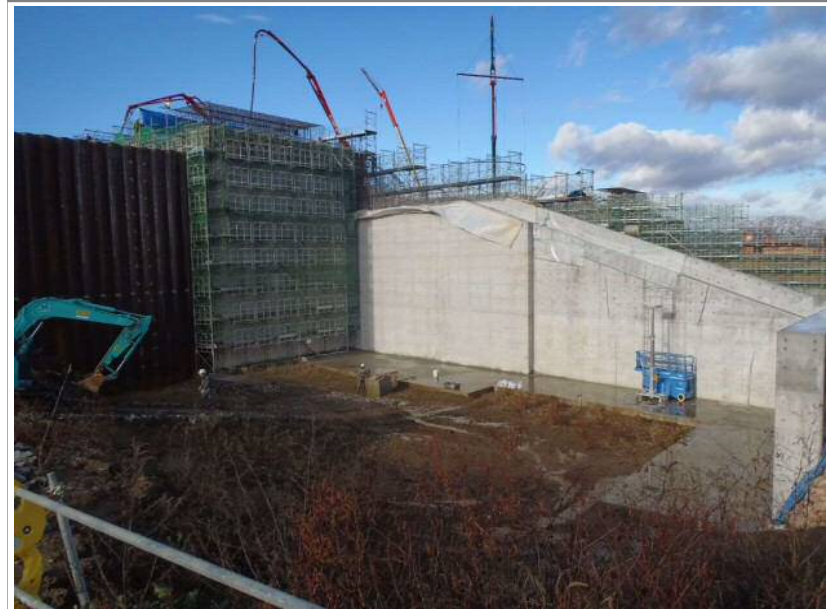
工事写真①
