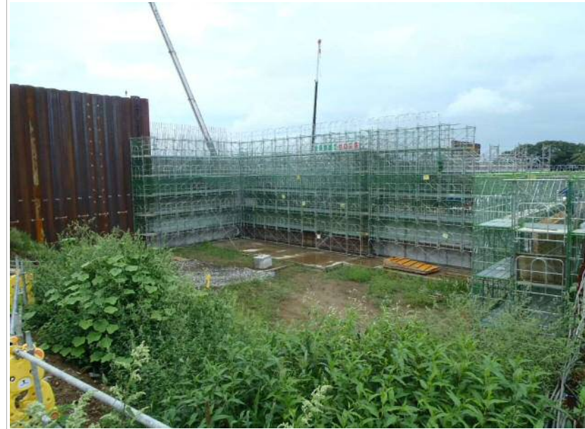
工事写真①
