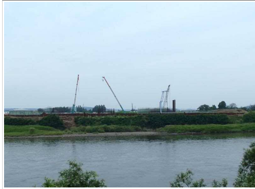
工事写真②
