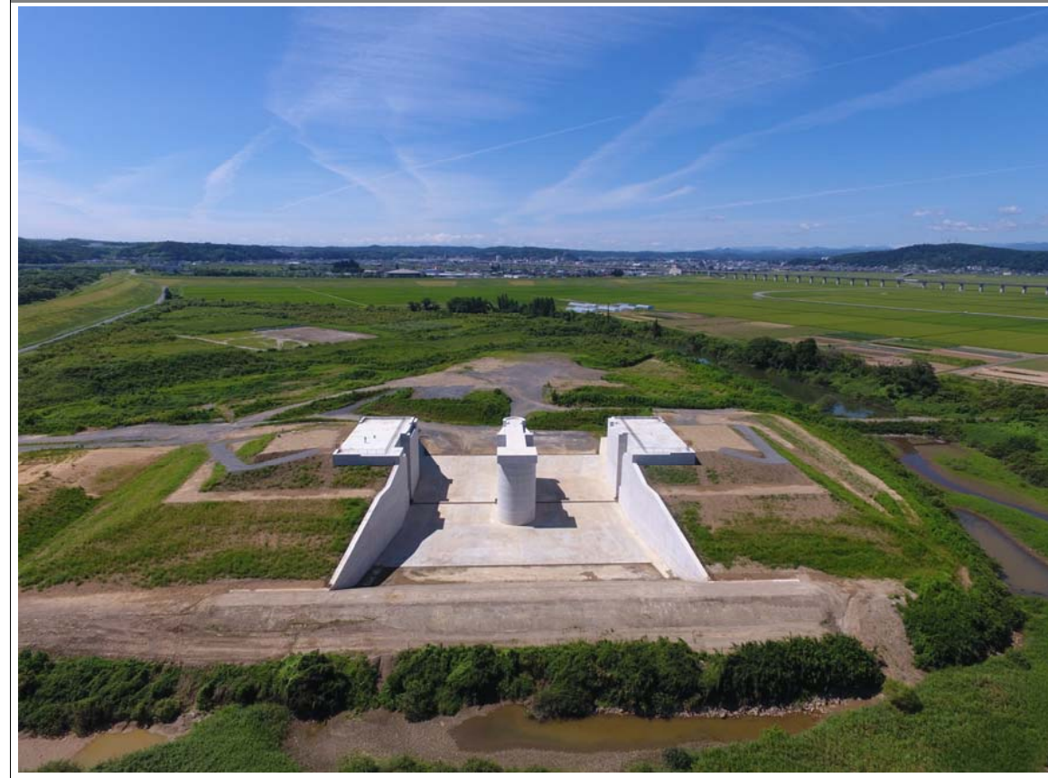
工事写真②
