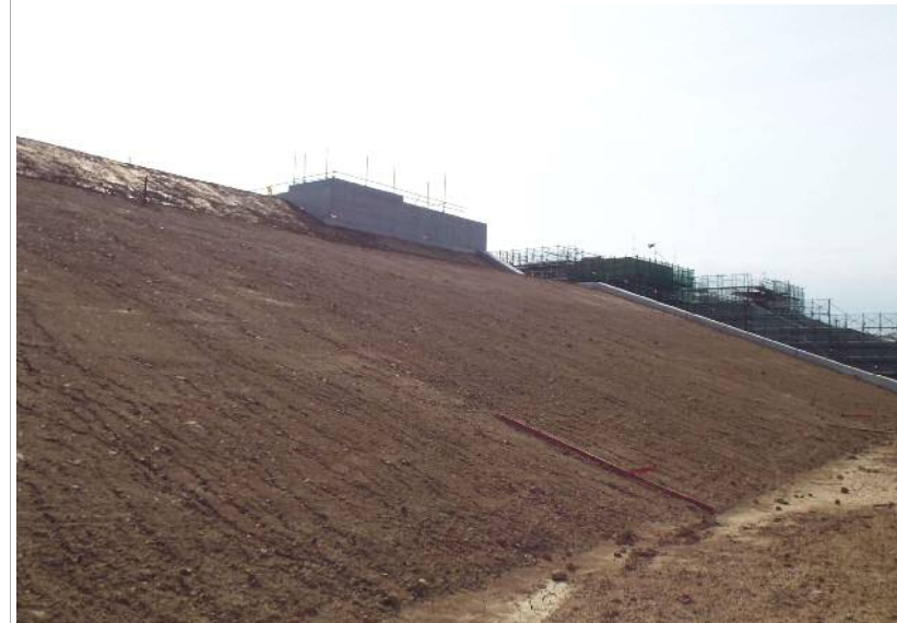
工事写真①
