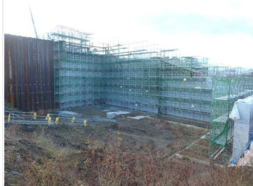
工事写真①
