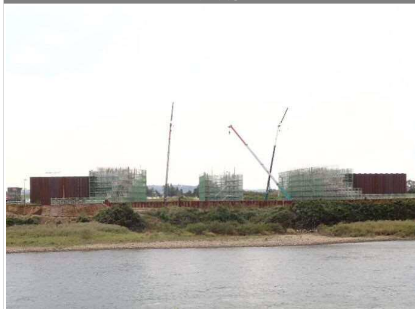
工事写真②
