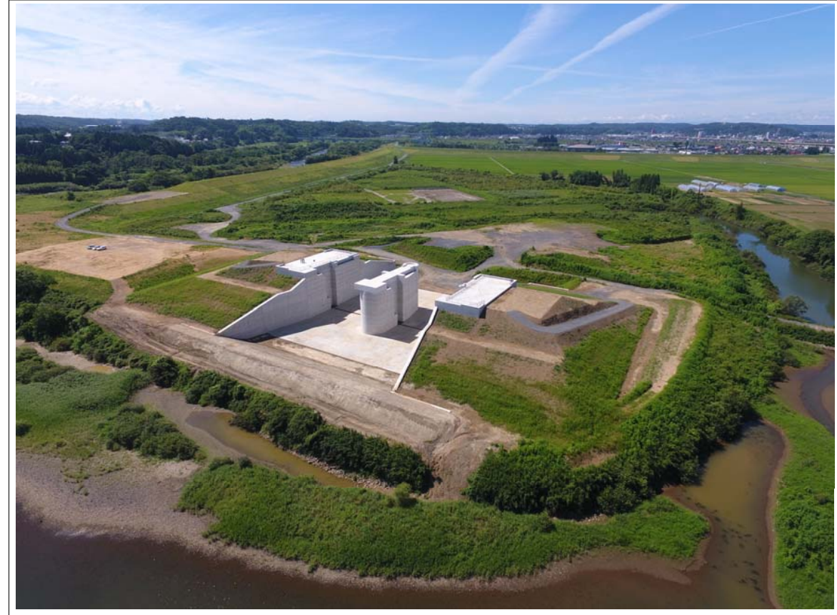
工事写真①
