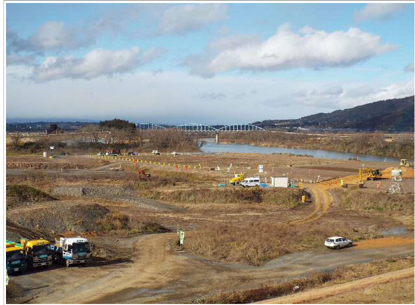
工事写真①
