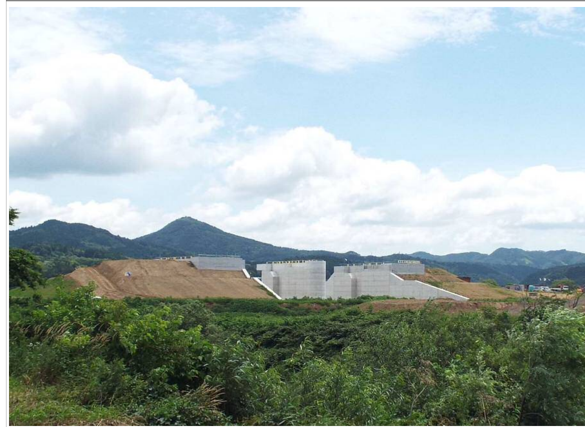
工事写真③
