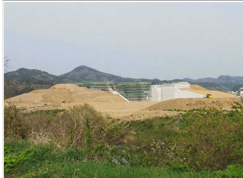
工事写真③
