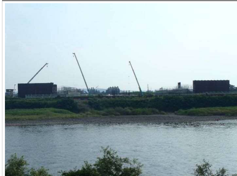
工事写真②
