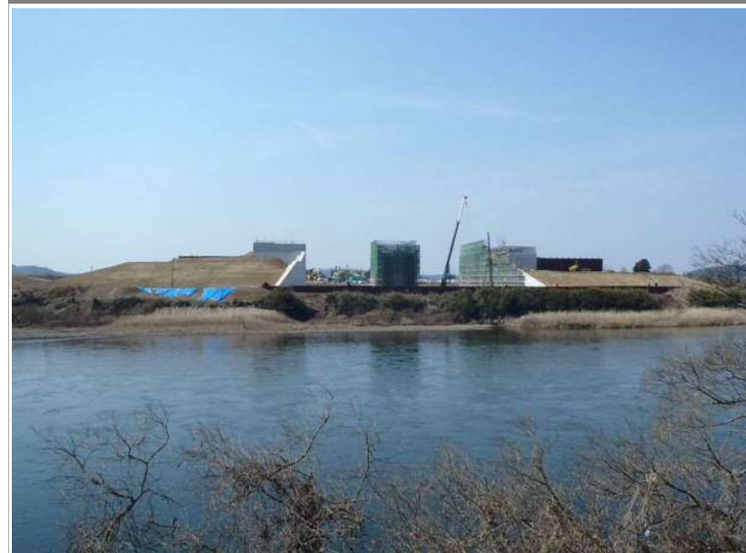
工事写真②
