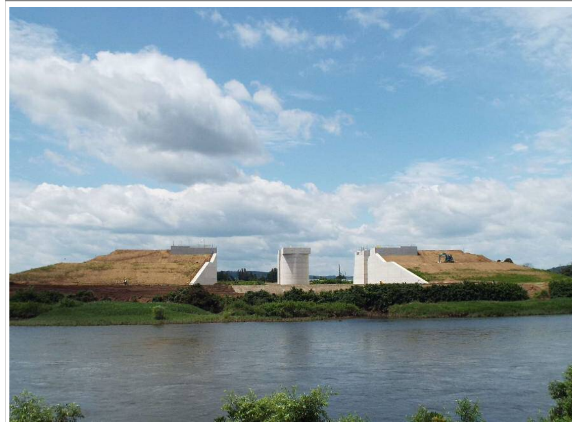
工事写真②
