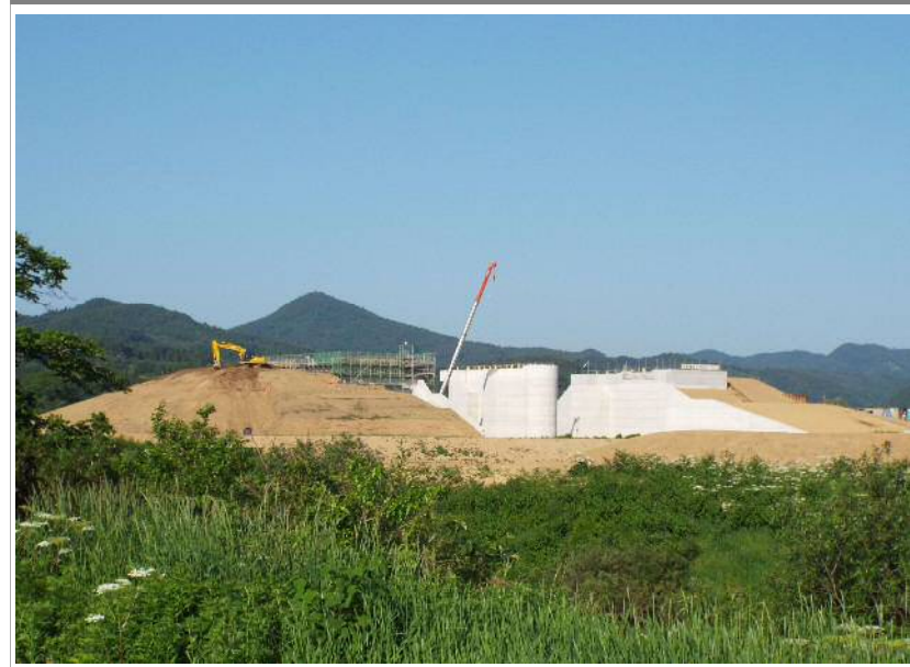
工事写真③
