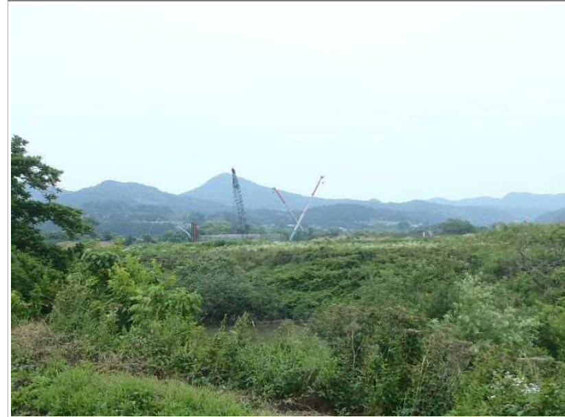
工事写真③
