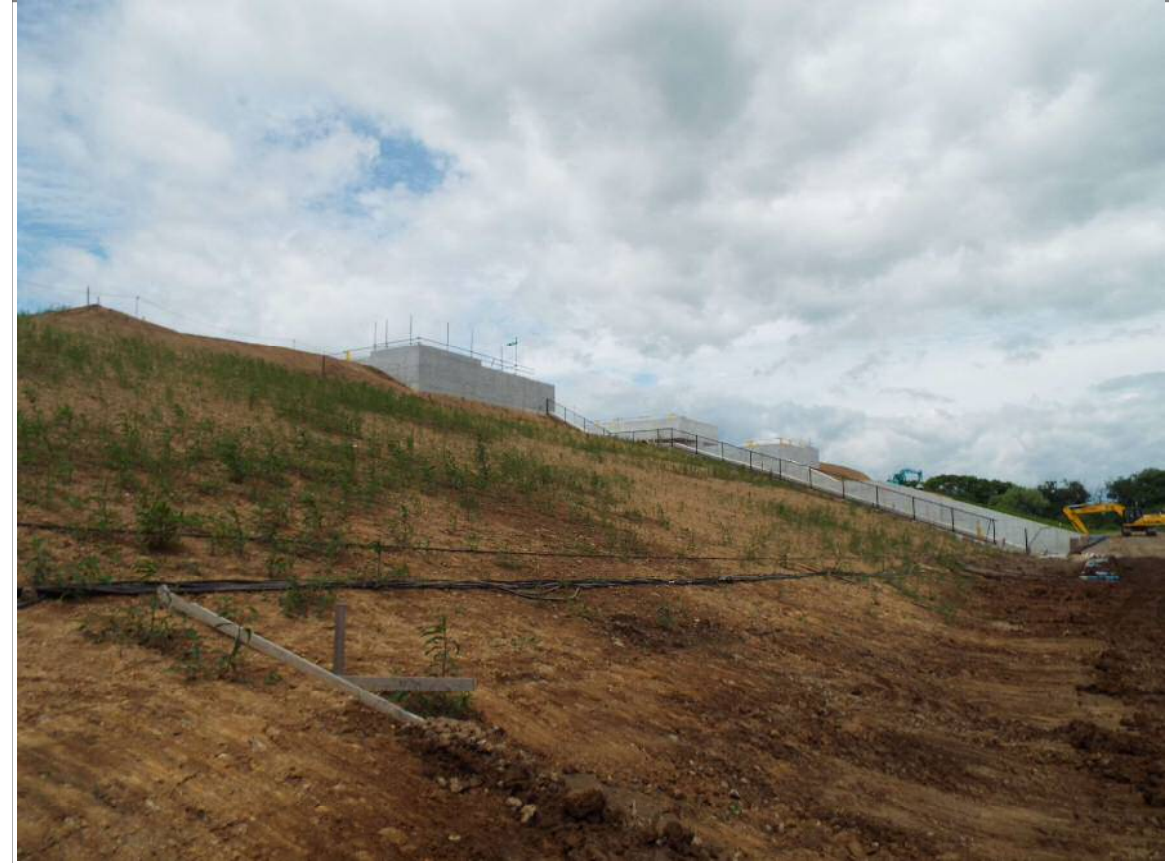
工事写真①
