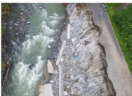
▲ ドローンを活用した被災状況調査
