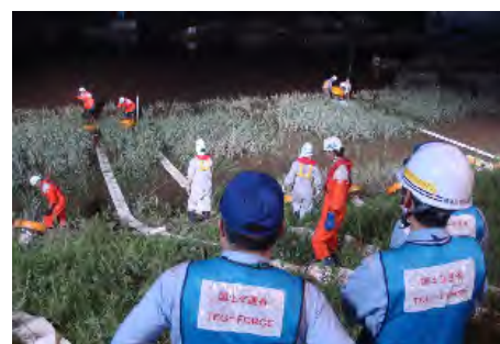
▲ 排水ポンプ車による排水活動
