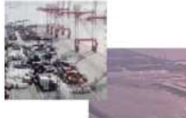
⑦神戸港・関空における浸水被害 (兵庫県神戸市、大阪府泉佐野市)
