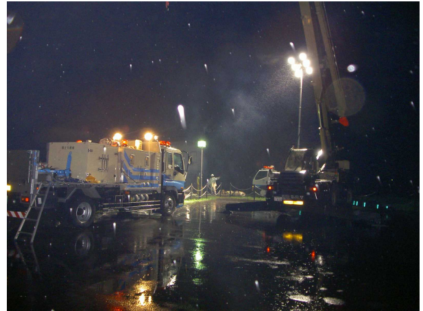
照明車による夜間作業の支援
