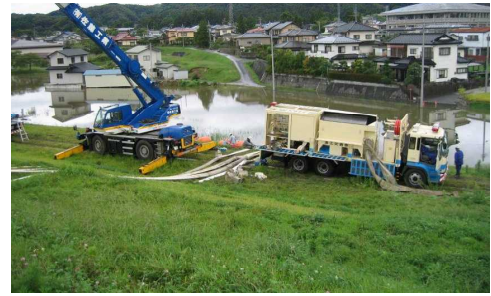
排水ポンプ車による排水活動状況
