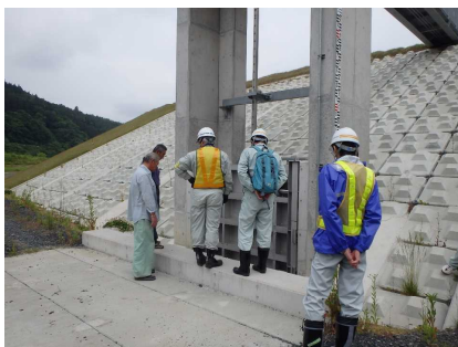
樋管のゲート点検状況
