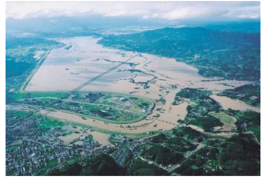
平成14年7月洪水による一関遊水地の状況
