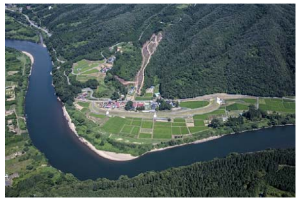
北上川狭隘地区治水対策事業の輪中堤整備状況 (一関市小日形地区)
