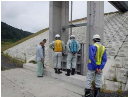
樋管のゲート点検状況
