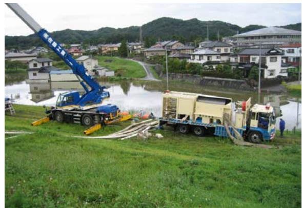
排水ポンプ車による排水活動状況 (平成19年9月洪水・平泉町倉町地区)
