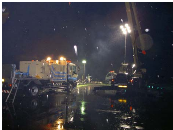
照明車による夜間作業の支援
