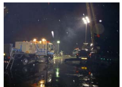
照明車による夜間作業の支援
