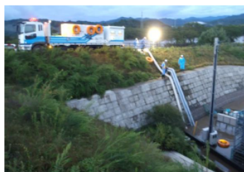
排水ポンプ車稼働状況(宮古市)
