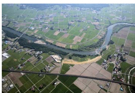
北上川中流部緊急治水対策事業の輪中堤整備状況 (紫波町 はたふく 甘木地区)
