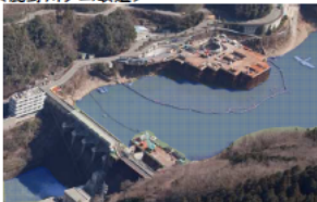
ダムを運用しながら、施設を改良
