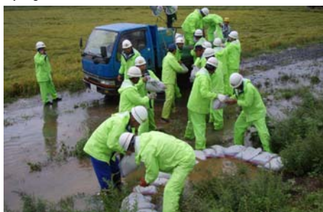
漏水発生箇所の水防活動状況 (平成19年9月洪水・奥州市姉体地区)
