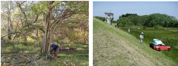
樹木伐採・除草の状況
