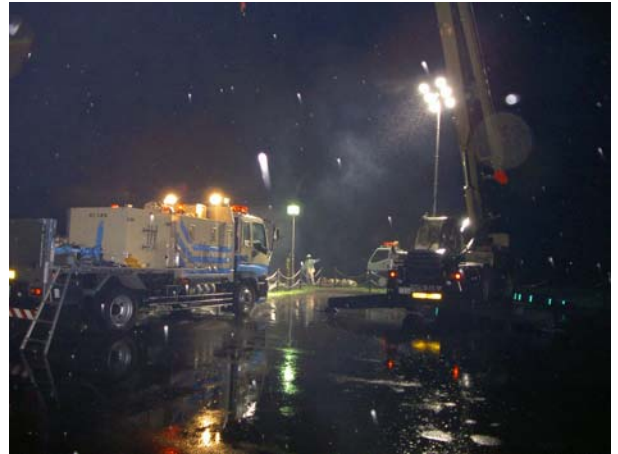
照明車による夜間作業の支援
