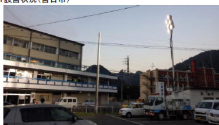
照明車稼働状況(岩泉町)
