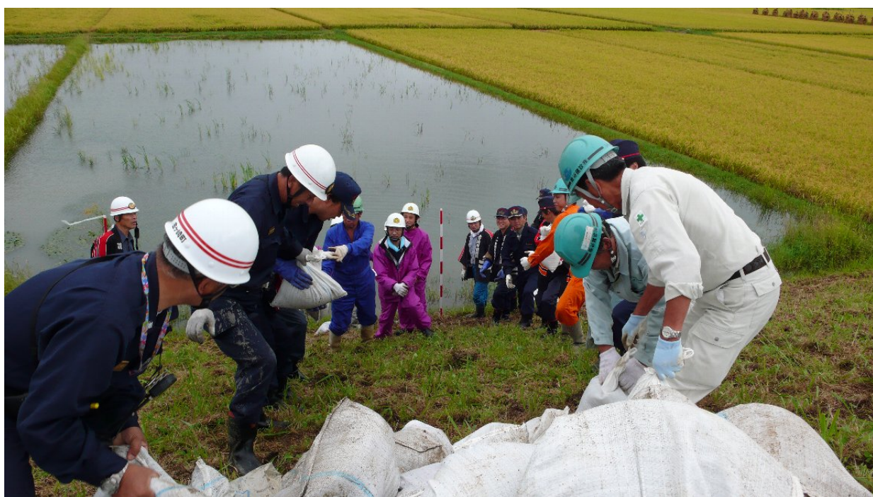
平成19年9月17日洪水 金ケ崎町三ヶ尻地区における水防活動
