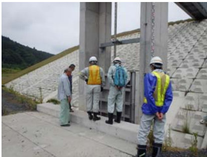
樋管のゲート点検状況
