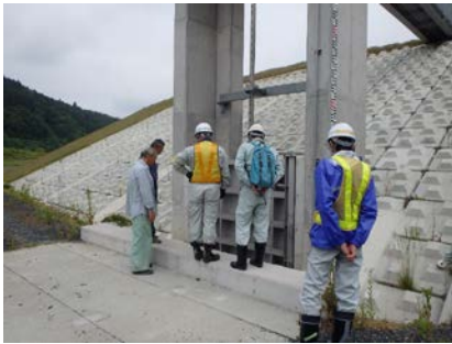
樋管のゲート点検状況
