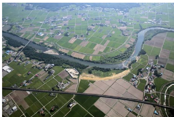
北上川中流部緊急治水対策事業の輪中堤整備状況 (紫波町甘木地区)
