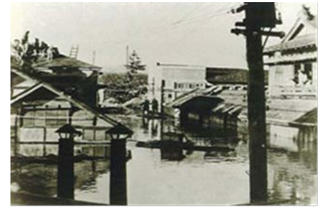
昭和22年9月（カスリン台風）による浸水被害状況（一関市中心部）
