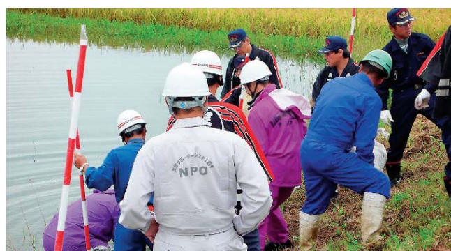
水防活動時における防災エキスパートによる工法指導
