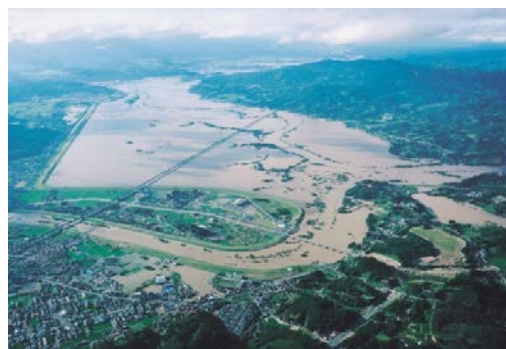
平成14年7月洪水による一関遊水地の状況
