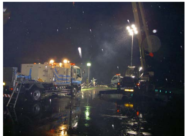
照明車による夜間作業の支援
