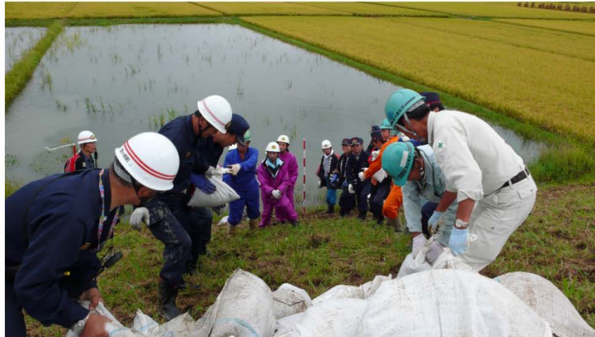
平成19年9月17日洪水 金ヶ崎町三ヶ尻地区における水防活動
