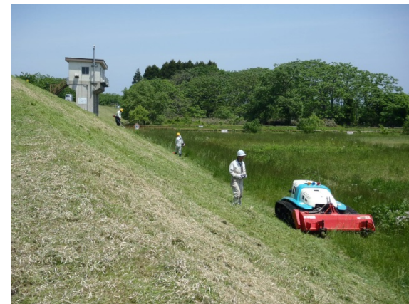
堤防除草の状況
