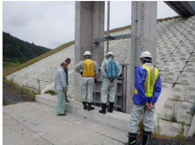
樋管のゲート点検状況
