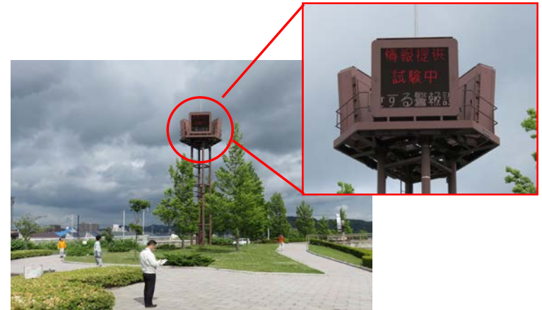
ダム放流警報施設による情報提供（写真は訓練状況）
