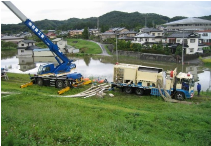
排水ポンプ車による排除活動状況 (平成19年9月洪水・平泉町倉町地区)
