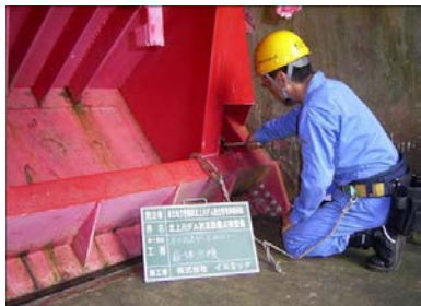
ダムの放流設備点検
