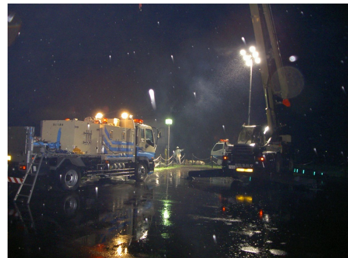
照明車による夜間作業の支援
