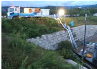
排水ポンプ車稼働状況(宮古市)
