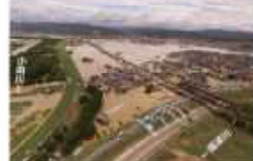
⑥小田川における浸水被害 (岡山県倉敷市)
