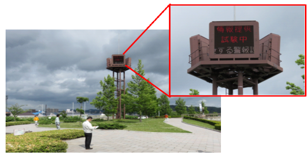
ダム放流警報施設による情報提供 (写真は訓練状況)
