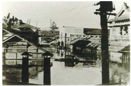
昭和22年9月（カスリン台風）による
