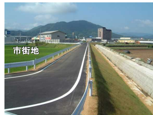
二線堤整備状況
