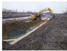
河道掘削 (石狩川水系、北海道開発局)
