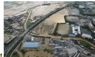
桂川における浸水被害 (福岡県朝倉市)
