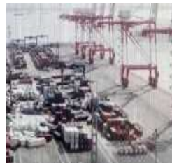
神戸港六甲アイランドにおける浸水被害 (兵庫県神戸市)
