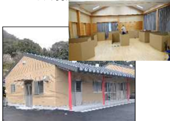
避難センターの整備
