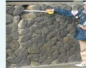
擁壁の危険度調査
