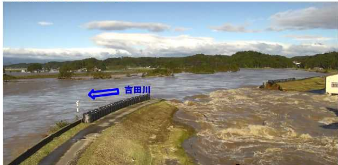
【吉田川左岸20.9k 破堤箇所】
