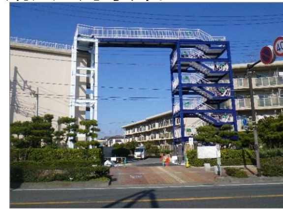
既存施設(市営住宅)への 避難階段設置
