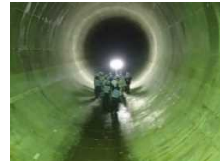
雨水貯留管の整備
