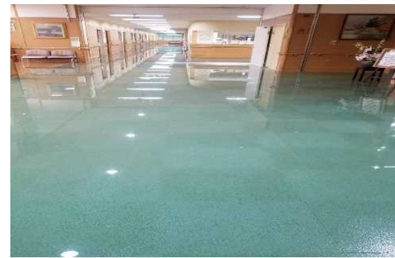
介護老人保健施設 舟形徳洲苑 浸水状況(平成30年8月6日)
