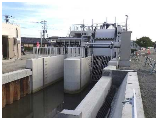
雨水ポンプ場の整備
