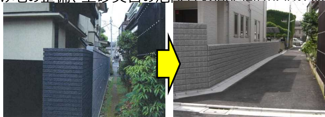
避難路整備(道路の拡幅)
