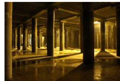
貯留施設の整備
