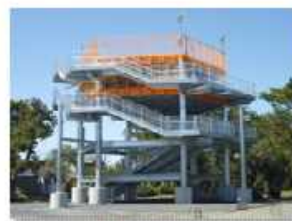
津波避難タワー
