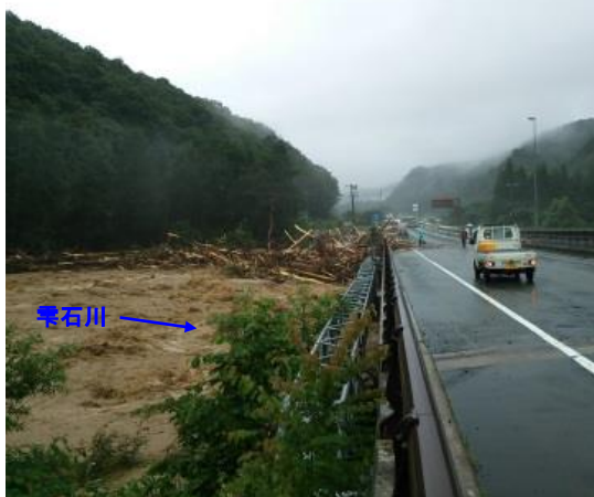
流木障害による堰上げ(雫石町橋場地区、国道46号)
