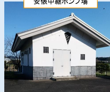
安俵中継ポンプ場
