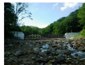
【治山：渓間工(一関市)】
