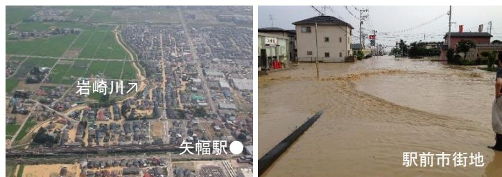
岩崎川の氾濫により市街地が冠水(平成25年8月)
