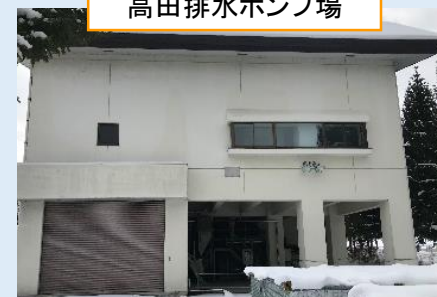
高田排水ポンプ場
