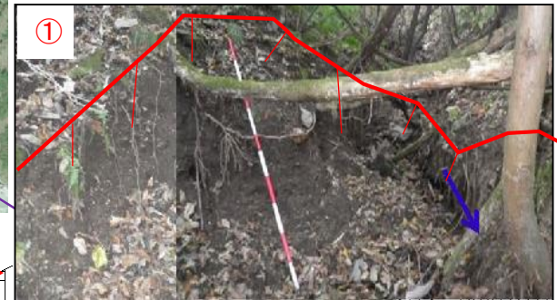
渓岸浸食状況
