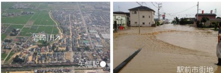
岩崎川の氾濫により市街地が冠水(平成25年8月)
