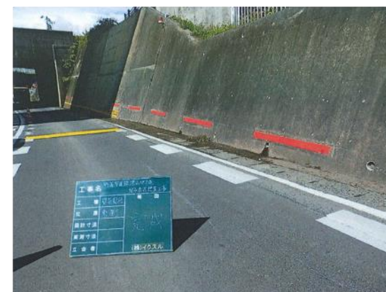
壁面浸水深表示
