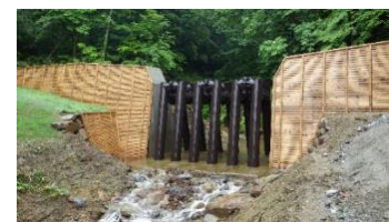
【治山：渓間工(雫石町)】
