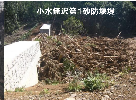
【小水無沢 流木補足事例(H25. 9月)】
