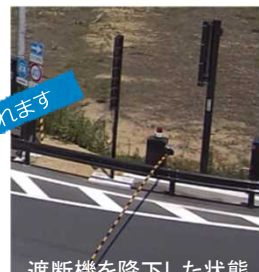
遮断機を降下した状態
