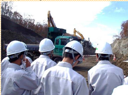
目の前で複数の重機が稼働している 様子に驚いていました。
