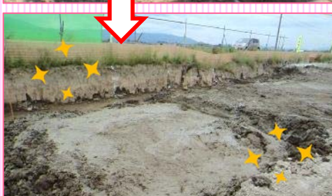
軟弱な土とセメントミルクを混ぜ合わせたら 2、3日で固まり、強度のある土に生まれ変わります!!
