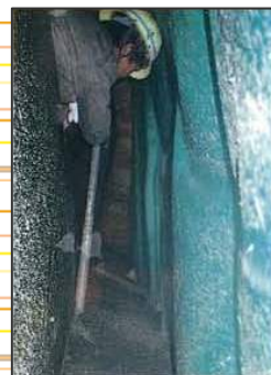
セントルと地山の間をコンクリートを流し込み、入念に締め固めます。
