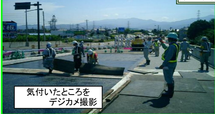
泉道路舗装工事現場点検
