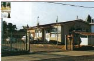
町庭坂に移転後の旧庁舎。
