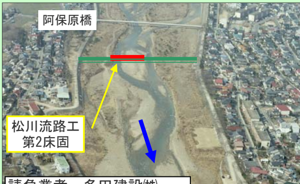
松川流路工第2床固
