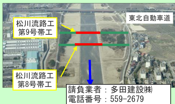
松川流路工第8号帯工・第9号帯工
