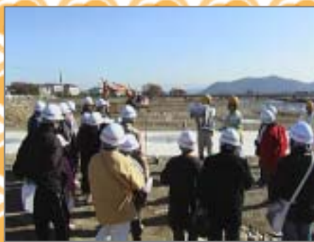
床固工はこのようにして造ります。
