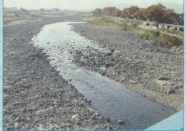
通常時 （11月8日午後、上松川橋から上流側を撮影）
