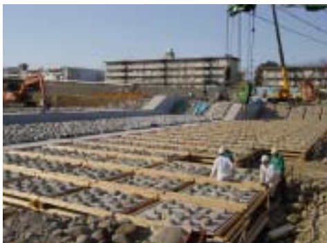
松川流路工第4床固工事の様子(H15.3月現在)
