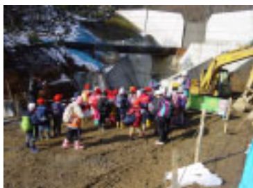
庭塚小学校1、2年生 高湯第一堰堤工事現場見学(H14.11.20)
