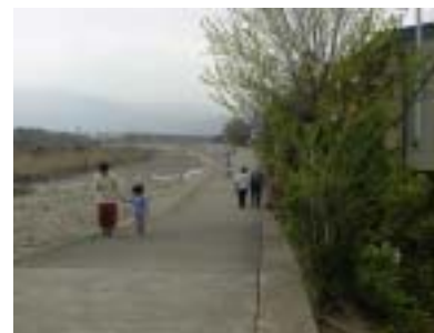
工事前の堤防の様子
