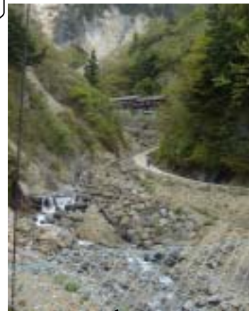
中央に石が積んであるのは、松川砂防出張所で施工した「床固工」です。道を歩いているのは宅急便のお兄さんです。
