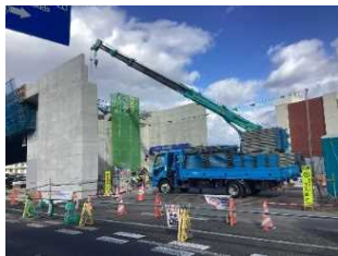
工事現場の様子
