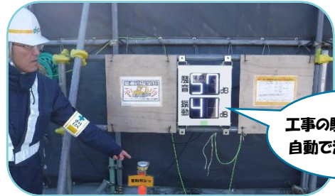
工事安全掲示板が設置されている
