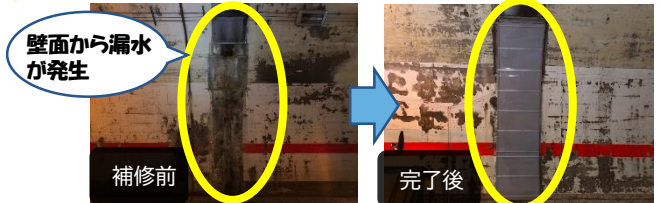
カバーを取り付け漏水対策
