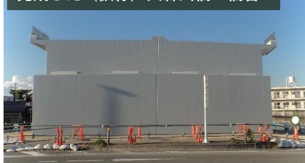
完成した(仮称)大森川橋の橋台
