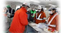
現場事務所を点検している様子
