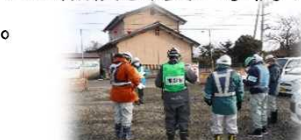
工事概要の説明を受けている様子
