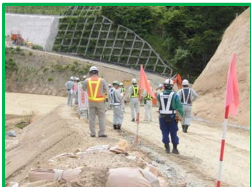
東北中央道 中野地区道路改良工事 受注者:太田建設(株)
