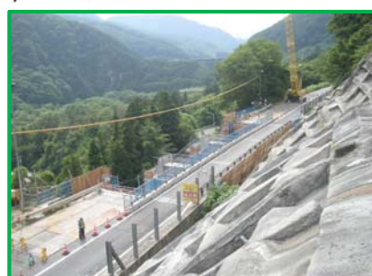
下り線 桁撤去まで完了
