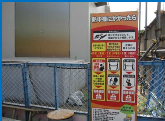
中野地区道路改良工事
