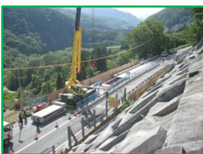
下り線 床版撤去の様子
