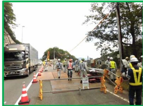
国道13号 籠岩橋外上部工補修工事 受注者:(株)小野工業所
