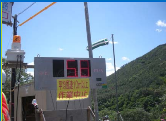
籠岩橋外上部工補修工事
