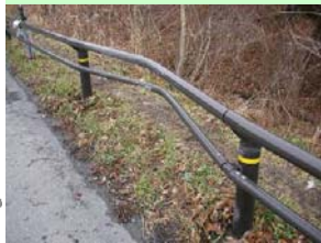
損傷した防護柵
