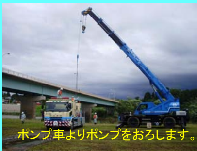
ポンプ車の使い方について、改めて職員より説明。
