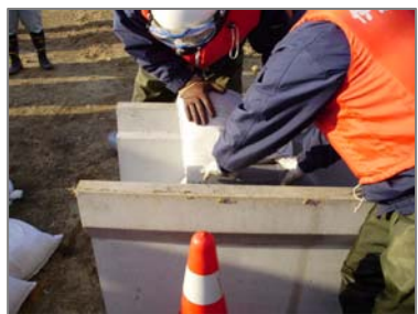
【側溝の油流出防止の設置方法】
