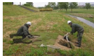
郡山水辺の小楽校の法面補修の様子
